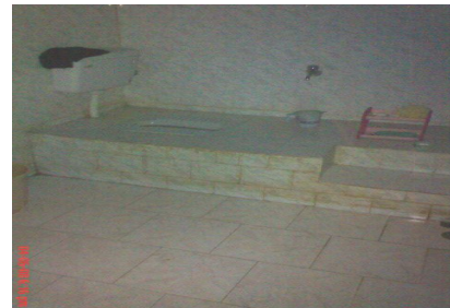
Bath cum toilet
